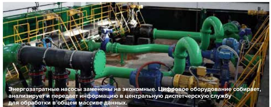
Энергозатратные насосы заменены на экономные. Цифровое оборудование собирает, анализирует и передает информацию в центральную диспетчерскую службу для обработки в общем массиве данных.
