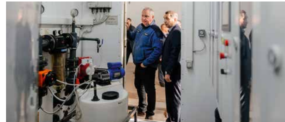
Установка по очистке воды, производительность – до 20 кубических метров очищенной воды в час. Во время визита на предприятие в мае этого года генеральный директор Роскосмоса Дмитрий Олегович Rogozin высоко оценил возможности использования таких установок.
